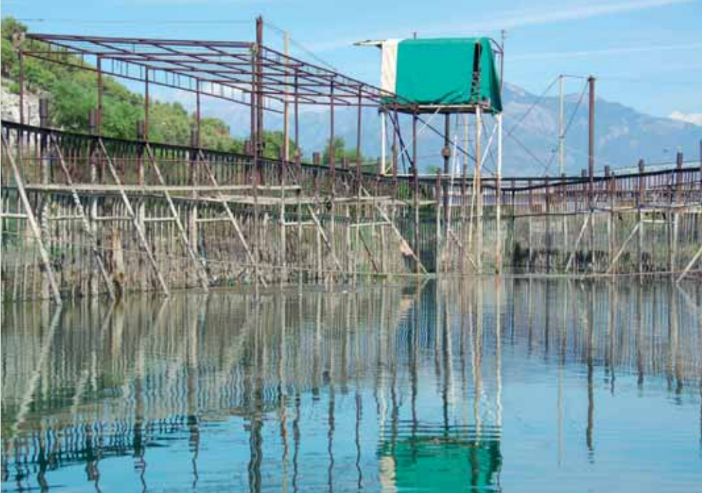
İç su balıkçılığında, balıkların bir tuzağa yöneltildiği yapılar olan su bentleriyle de balıkçılık yapılmaktadır. Fotoğrafta, Buna nehrinin İşkodra gölüne girişinde bulunan bent görülmektedir.
